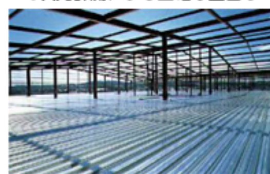
3次元計測による正確な墨出し
