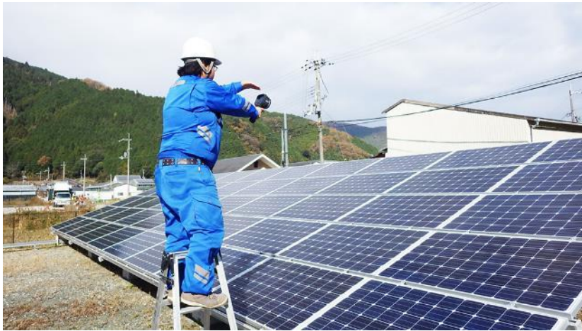
手作業での太陽光パネルの点検
